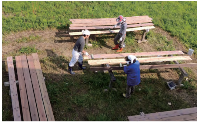
乾燥したところで欠点材を取り除いて塗装する。塗装は建て主DIYが多い
