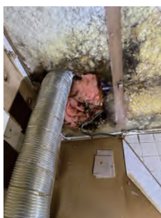
天井を撤去したところ。壁の断熱材は漏気の影響で一部が黒ずんでいる
