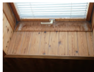
同じ建物でトップライトとして用いた木製断熱サッシ。いずれも結露の跡がある。当時の最高水準の窓だがトップライトについては断熱と気密、換気の調和という課題が残されていた
