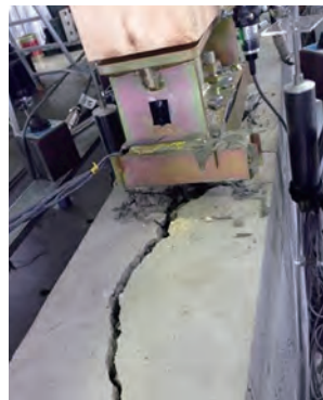
100kNの引き抜き力がかったところで基礎が割れた。鉄筋はシングル配筋。シングル配筋は帯筋などによりコンクリートと一体化されていないため、引っ張り力が生じると口が開くように割れる(写真提供:ウッド・ハブ)
