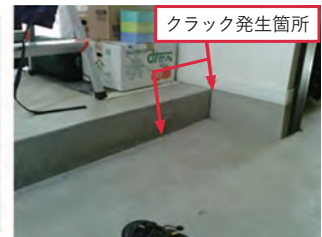
玄関部分は液状化により生じたクラックに沿って外気が侵入している。こうした漏気が確認できたのはこの場所のみ
