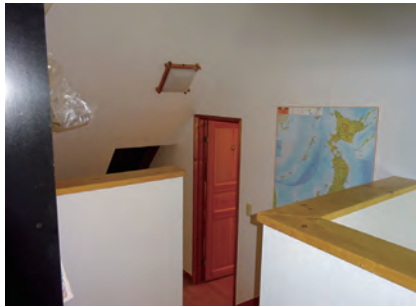
同じ建物の階段室まわり。雨漏りや結露の跡は見当たらない
