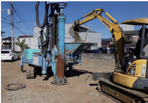
碎石を用いた柱状改良「エコジオ工法」の様子 (写真提供：尾鍋組)
