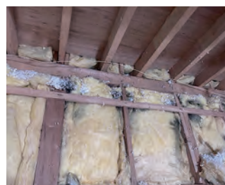
天井を撤去したところ。壁の断熱材は漏気の影響で一部が黒ずんでいる
