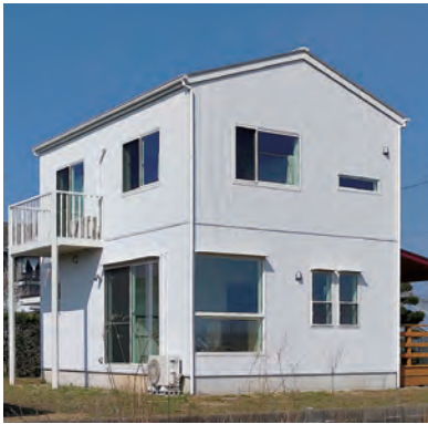
金属系サイディングで仕上げた住宅の外観。シーリング目地が目立たないのでボリュームを生かした表現に向く (写真提供：菅沼建築設計)
