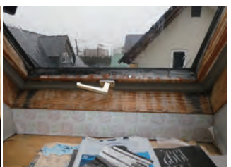
同じ建物でトップライトとして用いた木製断熱サッシ。いずれも結露の跡がある。当時の最高水準の窓だがトップライトについては断熱と気密、換気の調和という課題が残されていた
