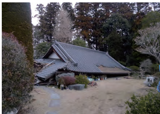
東日本大震災における地震被害の様子。海溝型地震でキラールパルスが含まれていると地震被害が大きくなることがある
