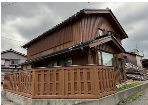
能登半島地震で無傷だった住宅（左写真の右の建物、右写真）。いずれも2000年に降に建てられたと予想される。耐震に配慮した設計を行えば木造住宅は大地震でも倒壊しない
