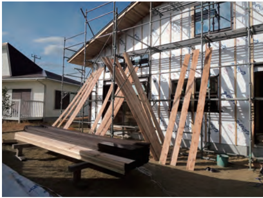
外壁用のスギ板を立てかけて乾燥させているところ
