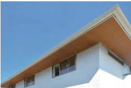
シーリングレスの窯業系サイディング「Fuge」の採用例 (写真提供：NASUホーム)
