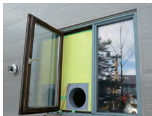
既存住宅の気密測定の様子
