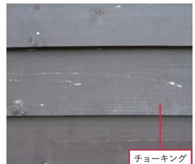
木材保護塗料の5年目の様子。溶剤系のよく知られた製品だがすでにチョーキングを起こしている。木材保護塗料の寿命は比較的短い
