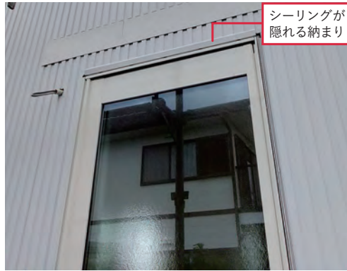
金属系サイディングの窓まわりの納まり。シールはジョイナーで隠される (写真提供：菅沼建築設計)
