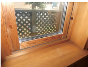
旭川市「ウッドタウン緑が丘」に建つ1990年竣工の住宅。写真撮影時は2017年。スウェーデンから技術導入をした木製断熱サッシを使用。大きな劣化は見られない
