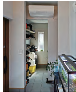
玄関収納に設けられたエアコン。主に暖房に用いている
