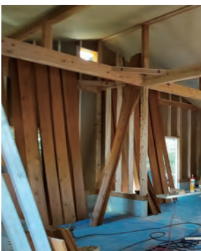
塗装した外壁用のスギ板を乾燥させているところ
