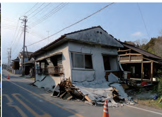
東日本大震災における地震被害の様子。海溝型地震でキラールパルスが含まれていると地震被害が大きくなることがある
