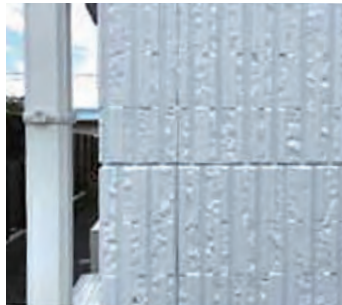
シーリングレスの窯業系サイディング「Fuge」の採用例(写真提供:NASUホーム)
