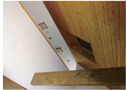
吹き抜け上の天井。このエリアも結露などの痕跡はない
