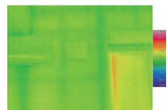
窓と換気口まわりの様子
