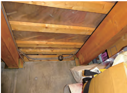
床下の様子。床の気密シートも正しく施工されており、健全な環境となっている。気密性能が保たれた建物は築30年近く経っても健全性を保っている
