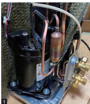
1 シングルロータリーのコンプレッサー。主に普及価格帯の機種に採用されている 2 ツインロータリーのコンプレッサー。容量が大きいため能力を高く設定できる。上位機種に採用されている 3 室内機の熱交換器。最近の機種は高効率化するために面積が大きくなっている 4 インバータの基盤。コンプレッサーのモーターを負荷に合わせてきめ細かく制御することで高効率化に寄与する
