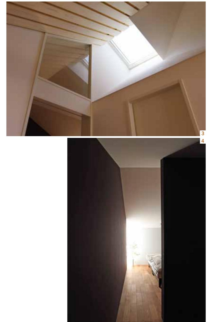
3 トップライト。屋根最頂部に設けて、上方の抜けをつくる
