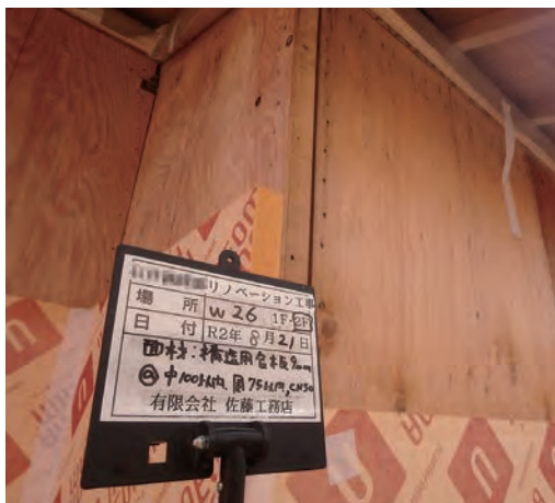
構造用合板の外側にフェノールフォーム45mmで断熱した事例。現場は埼玉県 (写真：佐藤工務店)
