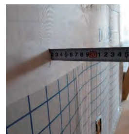
セルロースファイバーなど一部の断熱材は結露計算の上、防湿気密シートが不要になる(写真:建築工房小越)
