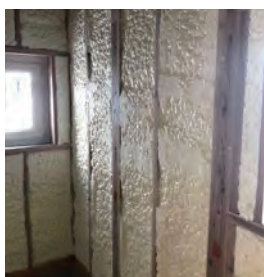
現場発泡ウレタンの100倍発泡も防湿気密シートが必要(写真:住まい環境プランニング西日本)
