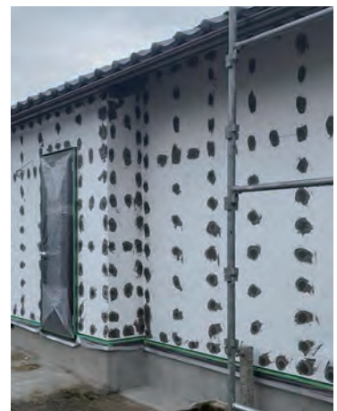
透湿性のあるEPSと左官材による湿式外断熱工法による性能向上リノベーションの例 (自然派ライフ住宅設計)
