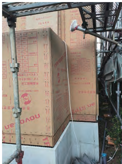
耐力面材に「ノボパン」を張った住宅。パーティクルボード系の耐力面材。耐力壁として粘りがあり、透湿抵抗も低い。バランスがよい耐力壁として評価されている
