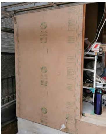
外壁側からの耐震改修に透湿性の高い「ハイベストウッド」を用いた事例 (写真：佐藤工務店)
