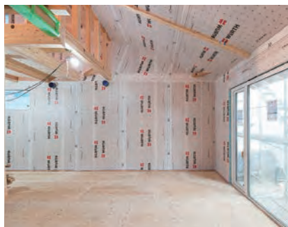
可変性気密シートを壁と天井に用いた事例 (写真：アーキテクト工房 pure)
