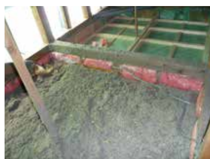
間仕切壁上部の気流止め施工状況
