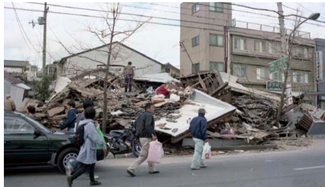
倒壊した木造家屋(写真提供:神戸市)
