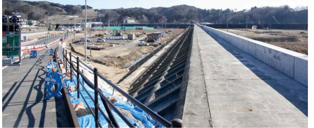
宮古市田老地区。道路築造や区画整理が進んでいる。右側が「万里の長城」とうたわれた防潮堤。かさ上げされた国道の外側は非居住エリアに、内側は宅地・商業地エリアに位置付けられている
