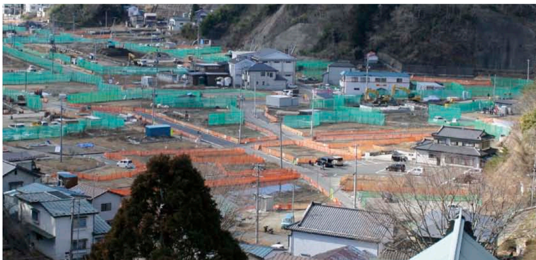
土地区画整理事業が進む宮古市鉾ヶ崎地区。これから住宅建設が本格化する
