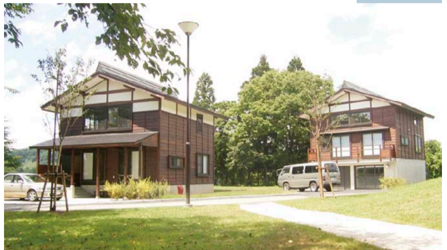
新潟県中越地震の復興住宅モデル棟 (左:低床タイプ、右:高床タイプ) 提供:アルセッド建築研究所
