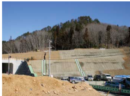
造成が進む田老地区の高台移転地。約160区画が整備され、災害公営住宅も建設される予定
