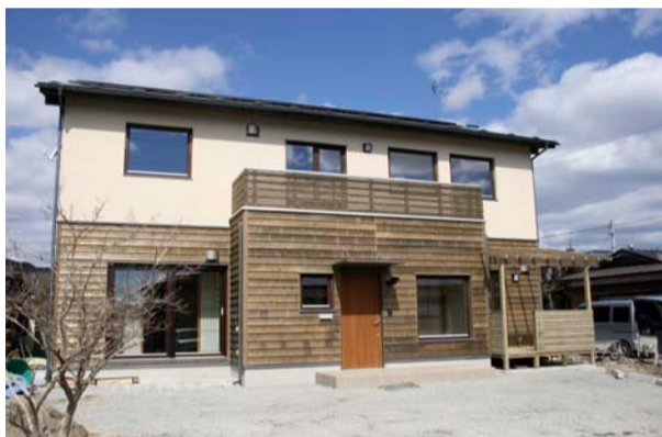
設計・施工は甲斐谷建築企画で、建物はQ値0.8、C値0.5の高性能。同プロジェクトは宮古の資源を使った性能のいい住宅を、地元業者の手で早く安価に供給する活動を行っている
