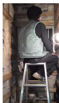
壁・床・天井を壊したのを機に断熱材と気流止めを施工
