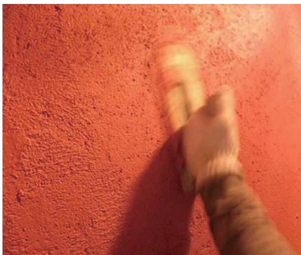
壁・天井はスペイン漆喰のコテ仕上げ
