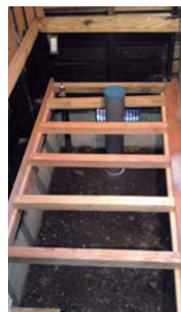
床下は防腐・防蟻処理。根太を下げて廊下との段差をなくす
